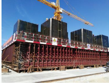
Caisson formwork
